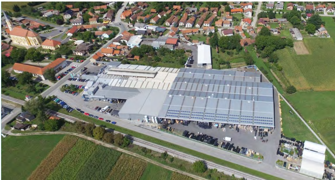
Tvrtka Centrometal d.o.o. - pogled iz zraka
