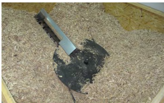
Spremnik sječke sa mješačem spojenim na transporter
