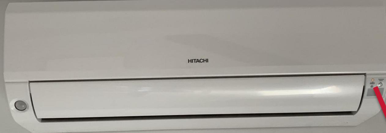
● Kada je u tijeku grijanje PTV-a, klapna jedinice se zatvara i svijetli lampica.
